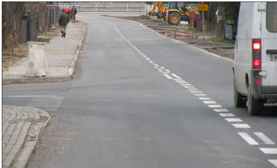
W Broniszewie ułożono nowy dywan asfaltowy przez całą miejscowość.
