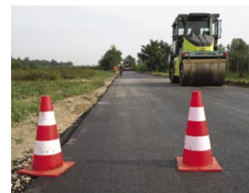
Zmodernizowana zosła droga powiatową Piekarty - Jadwigów na odcinku 3,8 km. Położono dywan asfaltowy oraz wyrównano pobocza.
