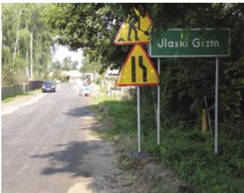
Została wykonana modernizacja drogi powiatowej Grzmiąca - Ulaski Grzmiąckie na odcinku 2,3 km.
