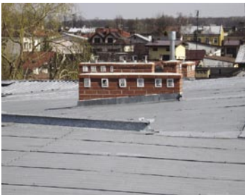
W Liceum Ogólnokształcącym została wymieniona pokrycie dachowe na budynku szkoły oraz wykonano nowe obróbki blacharskie.
