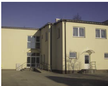
Trwa modernizacja Domu Pomocy Społecznej w Niedabyli. Stary budynek został rozbudowany i zmodernizowany, czyli przystosowany do standardów europejskich.
