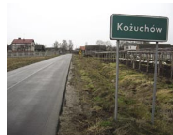
Zmodernizowana droga powiatowa w Kozuchowie.
