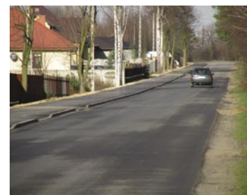
Droga powiatowa Białobrzegi-Suchastawiszyn została zmodernizowana. Wybudowano chodniki w Białobrzegach, ścieżkę rowerową i położono asfalt.
