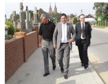
W Przybyszewie został wybudowany chodnik z kostki brukowej na odcinku od kościoła do cmentarza (400 m). Inwestycję zrealizowaliśmy wspólnie z Urzędem Gminy Promna.
