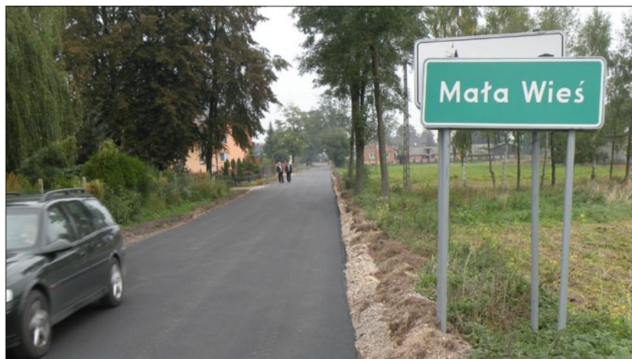
Wyremontowana droga powiatowa Osuchów - Mała Wieś (gmina Promna).
