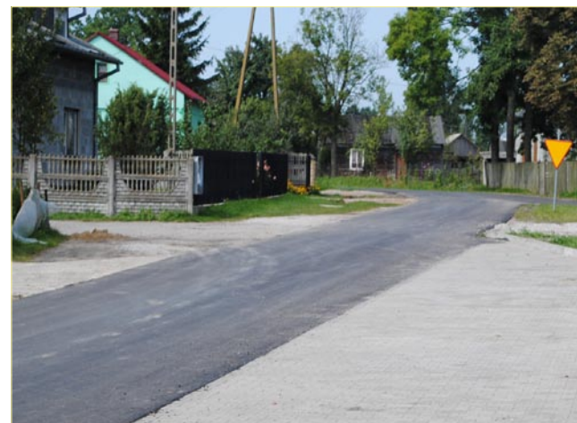
W Kadłubku powstał przystanek autobusowy i drogę pokryto asfaltem.
