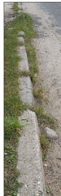
Będą zmiany nawierzchni i chodnika.
