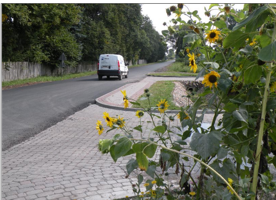
Dzięki modernizacji drogi autobusy PKS będą kursować regularnie.
