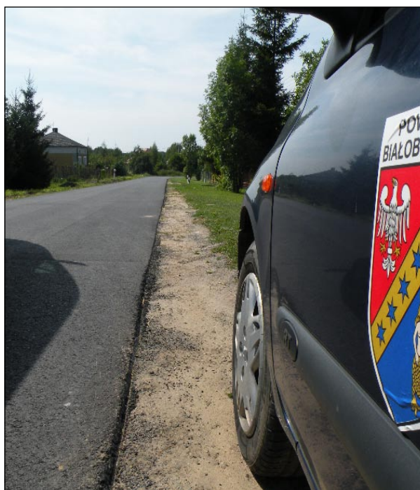
Nowy asfalt na drodze i wyrównane pobocza ułatwią życie kierowcom.
