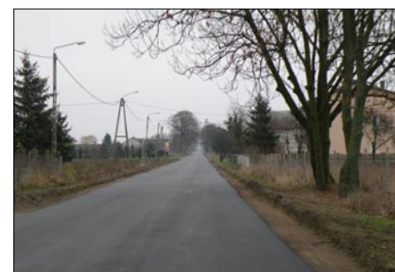
W Olszamac droga zyskała nową nawierzchnię.
