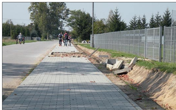
Prace na drodze zmierzają do końca.
