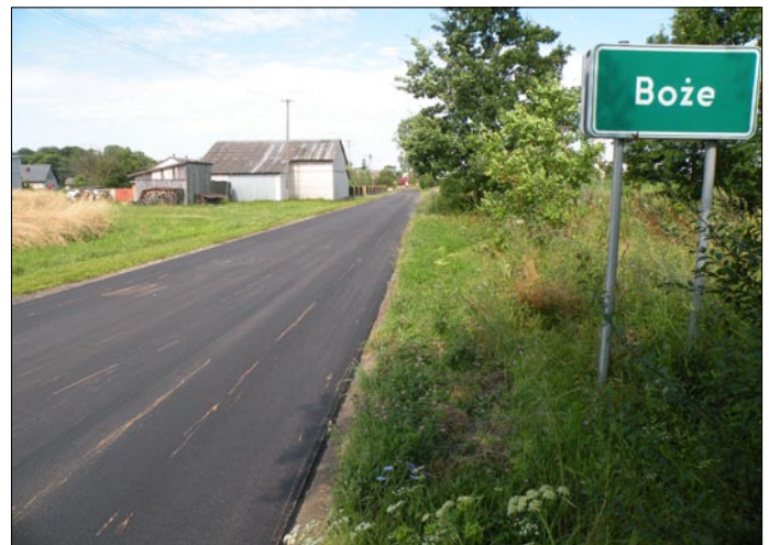
Zmodernizowany odcinek drogi powiatowej.
