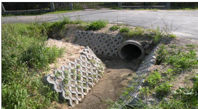
W Ksawerowie Nowym (gmina Stromiec) naprawiono uszkodzone przepusty pod drogą powiatową.
