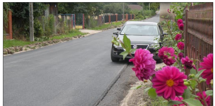
Na całej długości drogi powiatowej w miejscowości Rykały położony jest nowy dywan asfaltowy.
