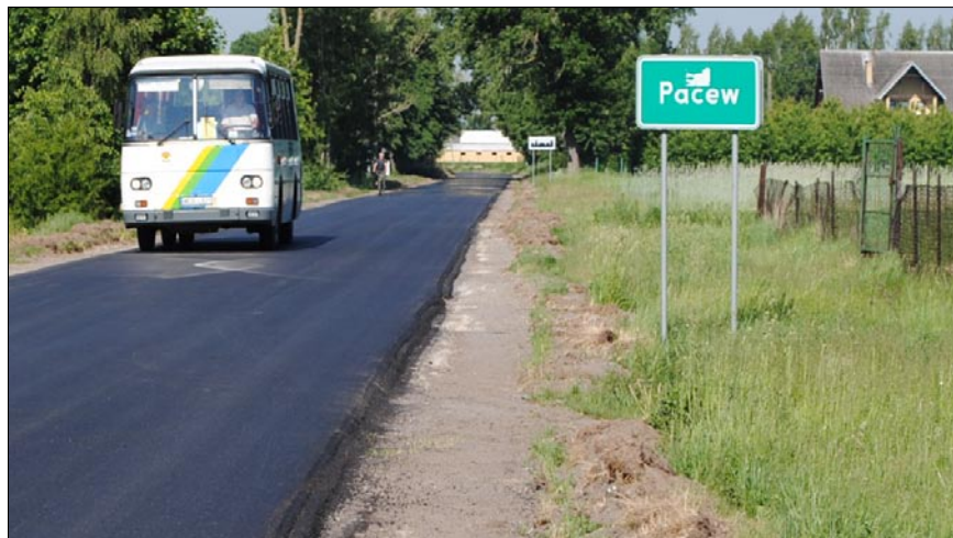
Droga Adamów - Pacew - Przybyszew ma nową nawierzchnię.
